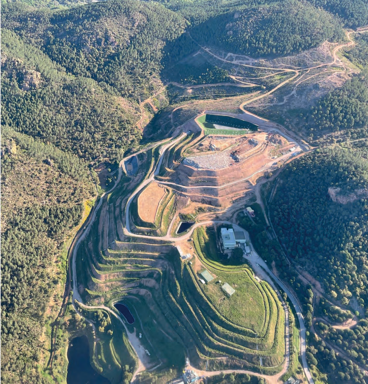
Vue aérienne de l'ISDND – Mai 2021
